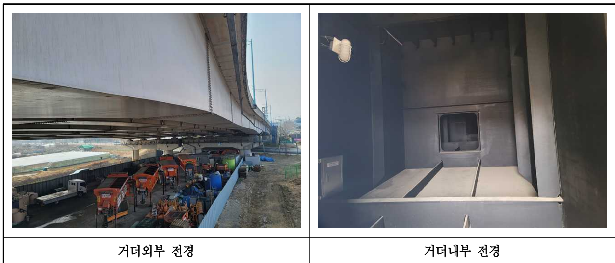
【사진 2.3.4】 거더 전경
