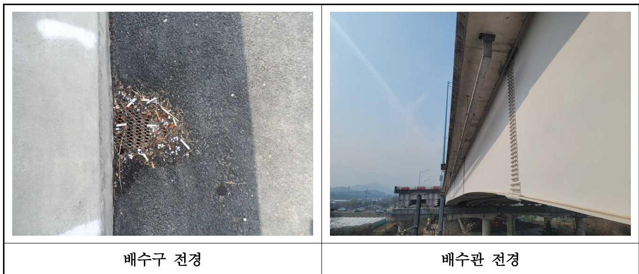
【사진 2.3.53】 배수시설 전경
