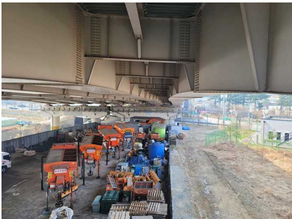
교각 P2 상태현황
