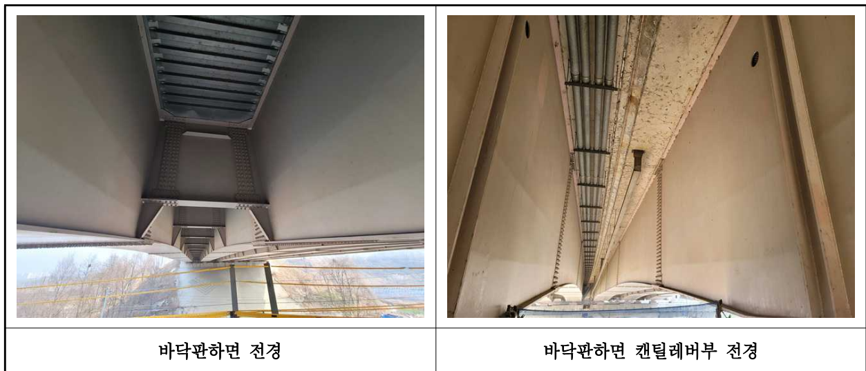
【사진 2.3.2】 바닥판하면 전경
