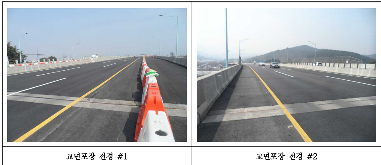
【사진 2.3.51】 교면포장 전경
