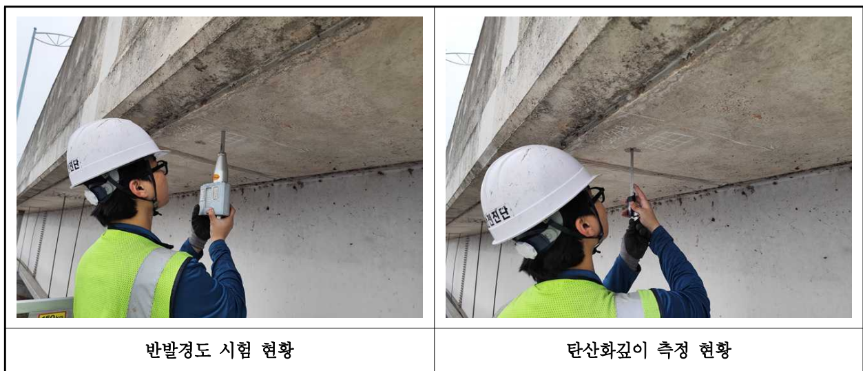
【사진 2.4.1】 콘크리트 내구성조사 현황
