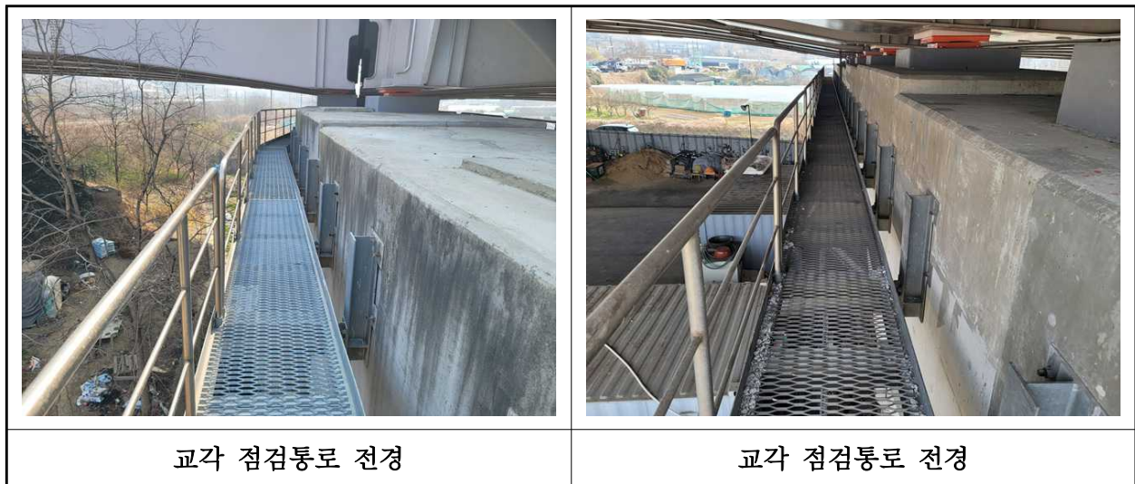
【사진 2.3.27】 교량 점검시설 전경
