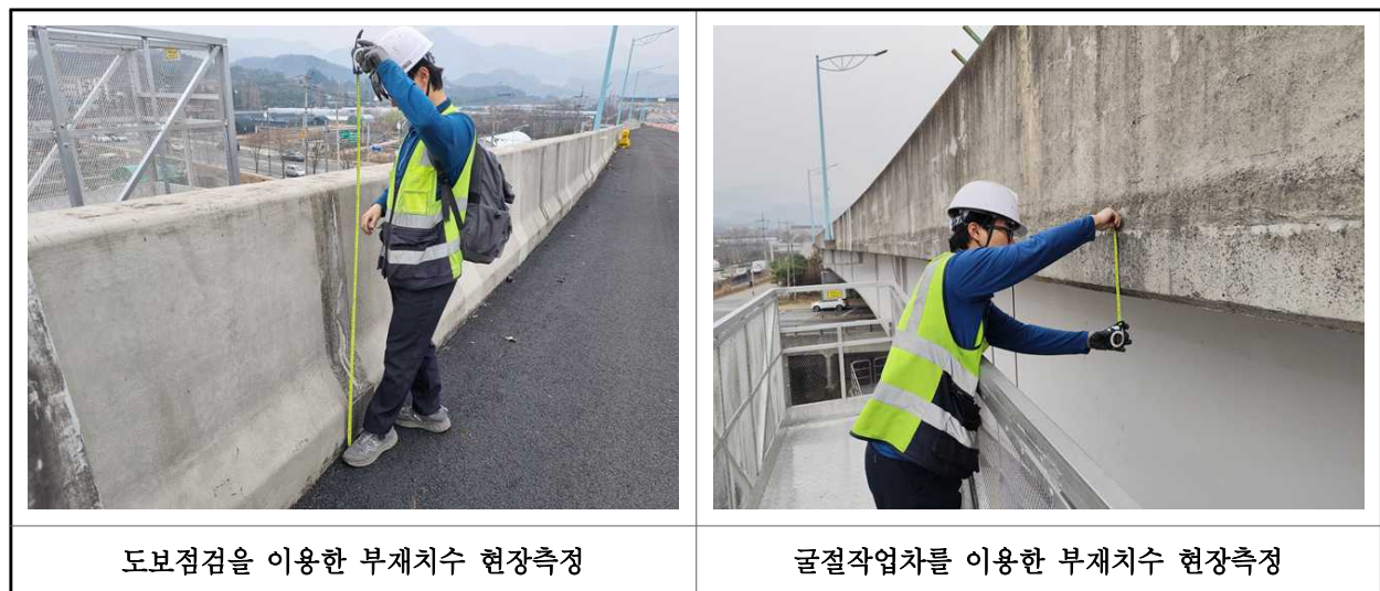
【사진 2.2.1】 부재 현장측정 전경
