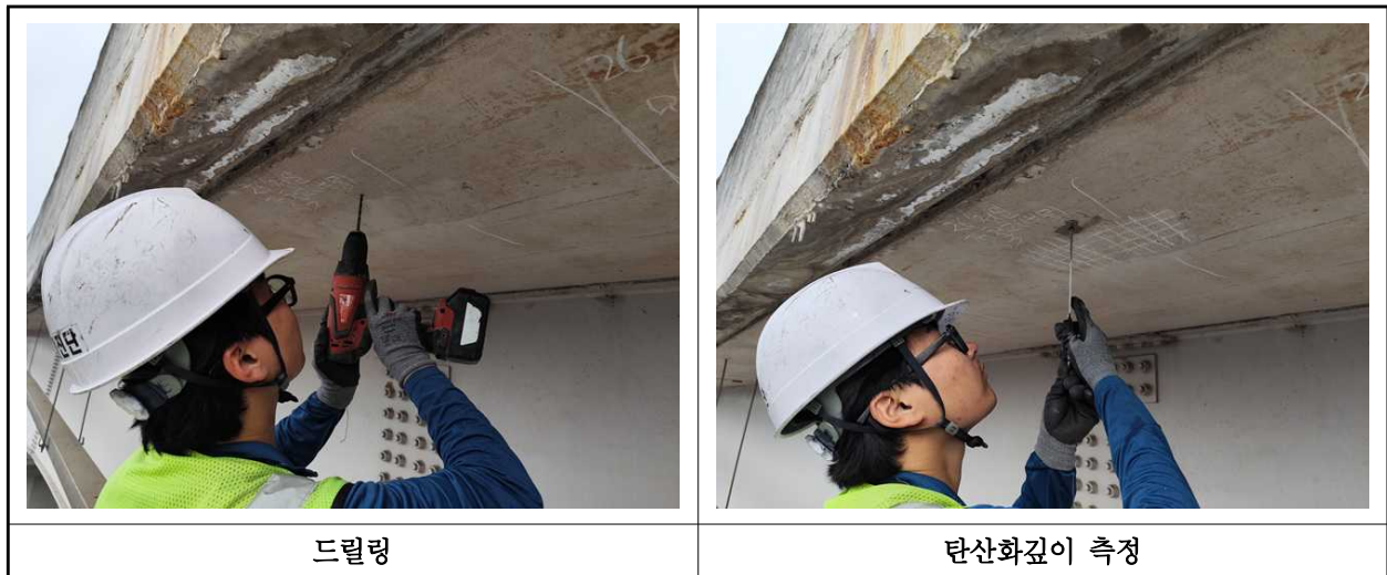
【사진 2.4.3】 탄산화 깊이 측정 현장사진
