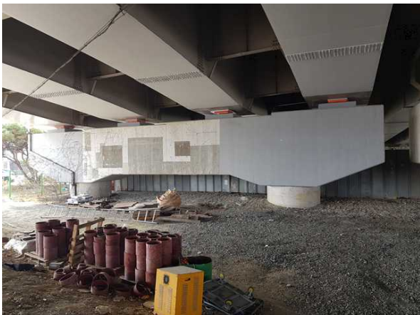
교각 P1 상태현황
