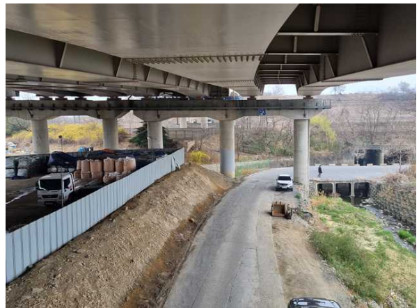
교각 P3 상태현황
