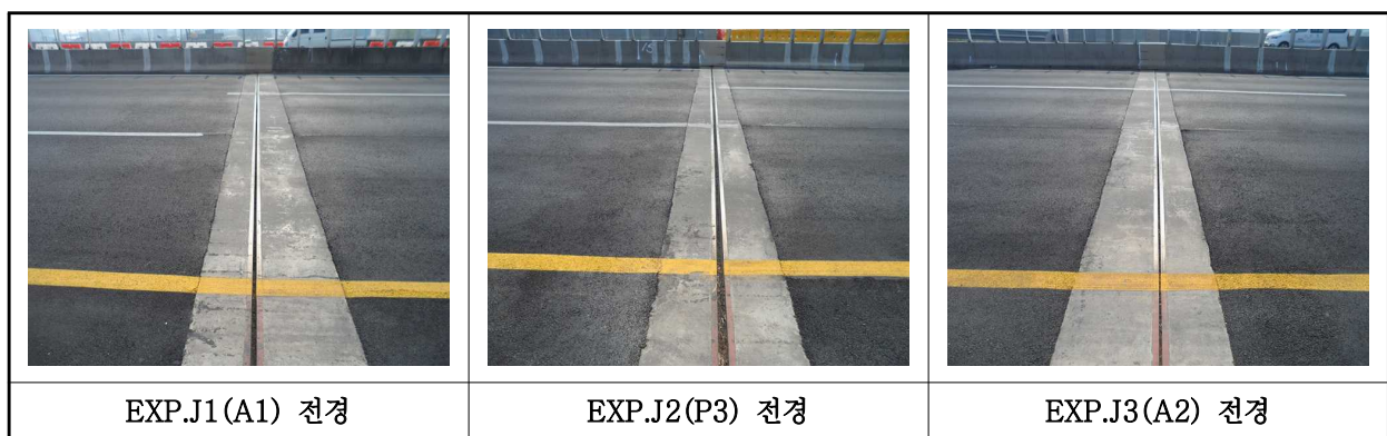
【사진 2.3.18】 신축이음장치 전경
