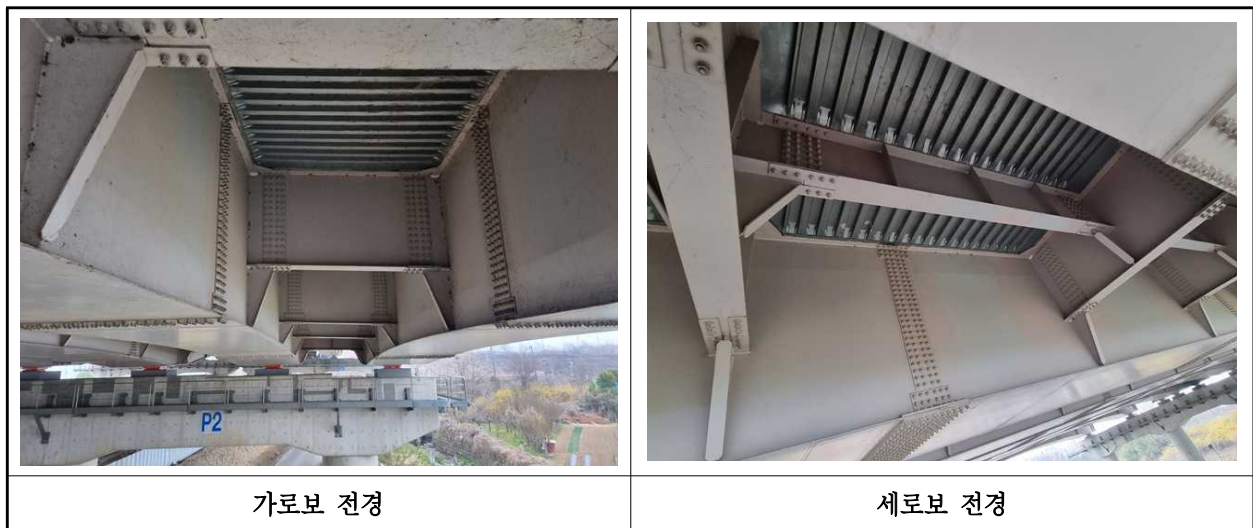
【사진 2.3.36】 가로보 및 세로보 전경
