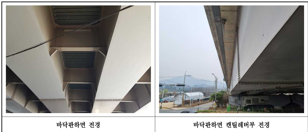
【사진 2.3.32】 바닥판하면 전경
