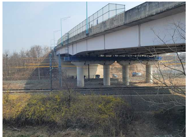
교각 P4 상태현황
