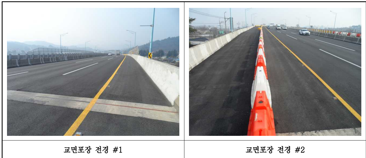
【사진 2.3.21】 교면포장 전경
