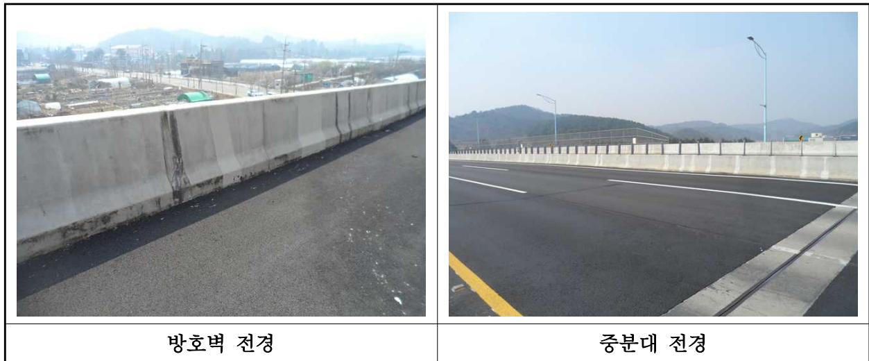
【사진 2.3.55】 방호벽 및 중분대 전경
