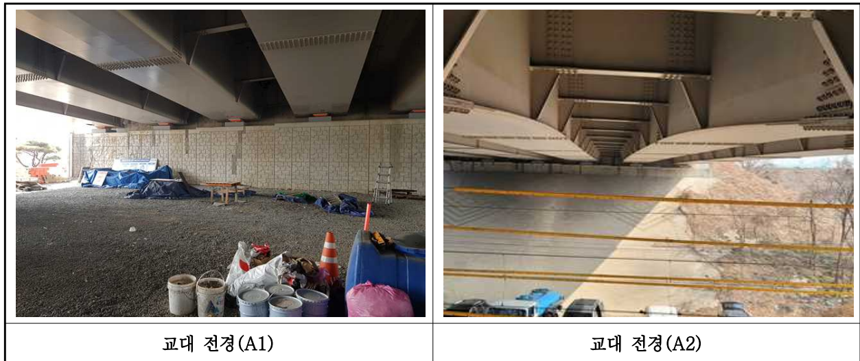
【사진 2.3.38】 교대 전경
