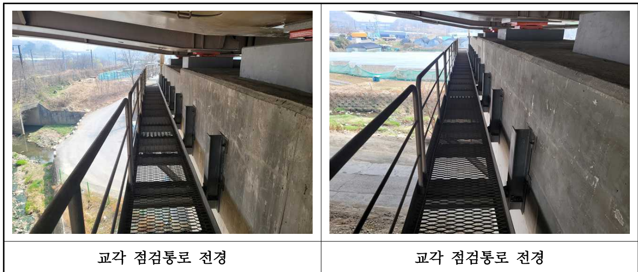
【사진 2.3.57】 교량 점검시설 전경
