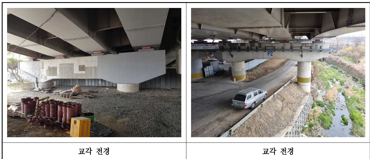
【사진 2.3.41】 교각 전경
