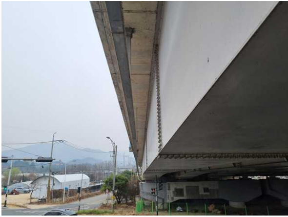
바닥판하면 S3 외측 캔틸레버 상태현황
