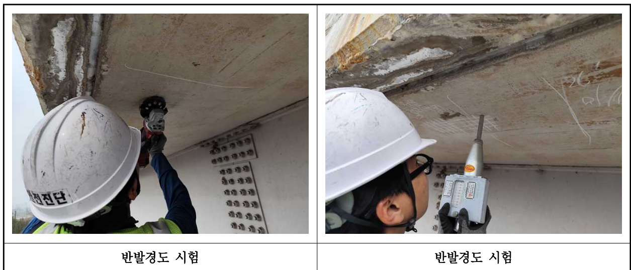
【사진 2.4.2】반발경도시험 현장사진
