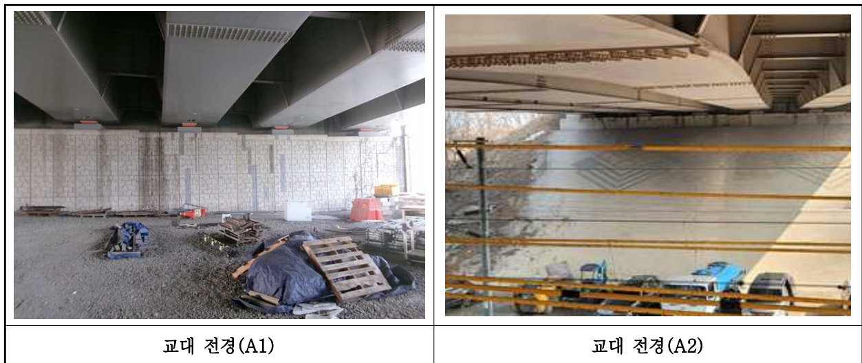
【사진 2.3.8】 교대 전경
