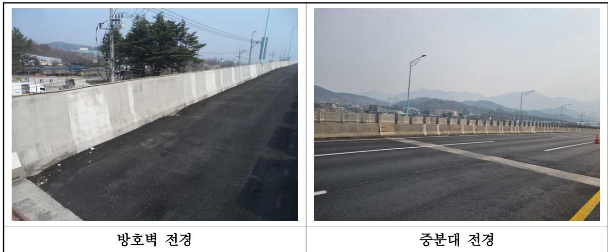
【사진 2.3.25】 방호벽 및 중분대 전경
