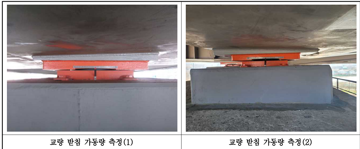
【사진 2.3.47】 교량받침 이동량 측정
