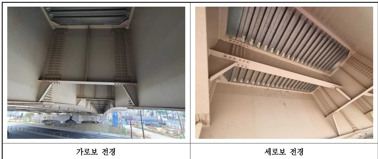
【사진 2.3.6】 가로보 및 세로보 전경
