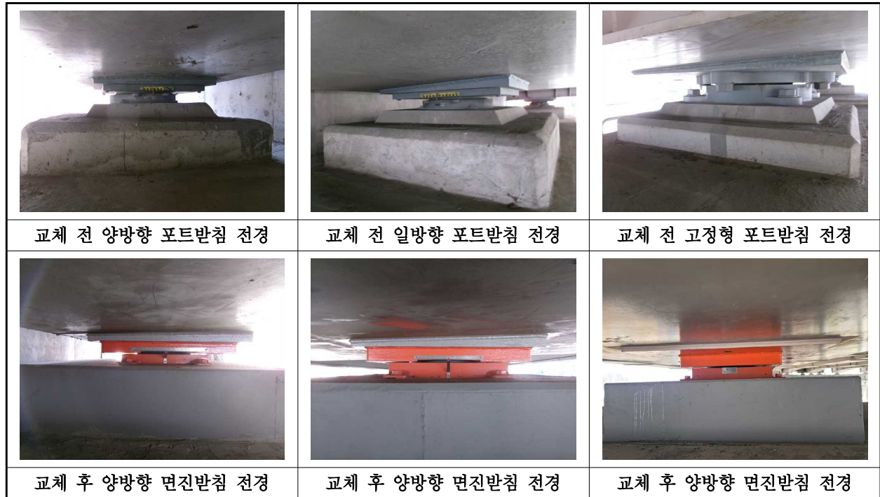
【사진 2.3.14】교량받침 전경
