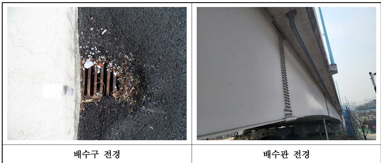
【사진 2.3.23】 배수시설 전경
